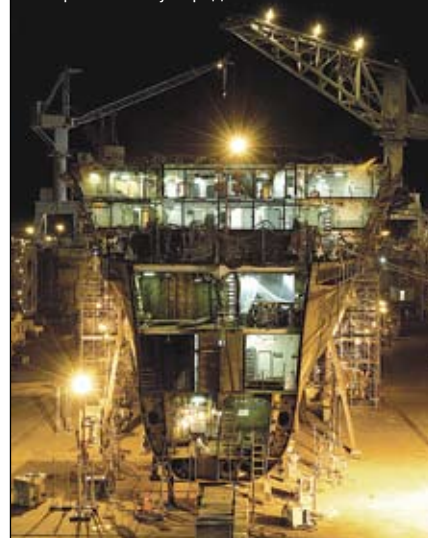
Строительство современного судна невозможно без применения углеродных волокон
